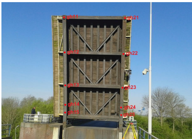
Voorbeeld foto onderkant brug in geheven toestand
