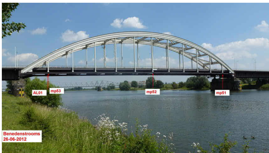
Voorbeeld 2 overzichtsfoto benedenstrooms
